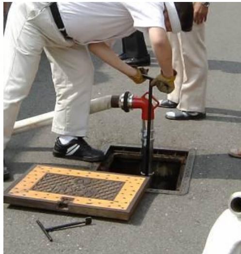
消火ノズルの保持を中継者から確認し消火栓を開けます。
