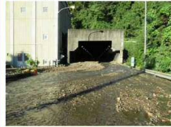
小仏トンネル東坑口付近 規模:幅 約300×高さ 約15m(約500㎡)
