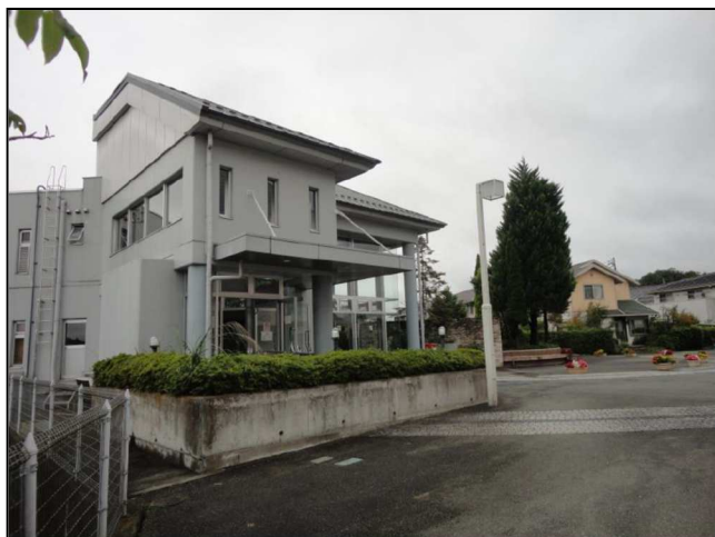
高木伐採完了後
