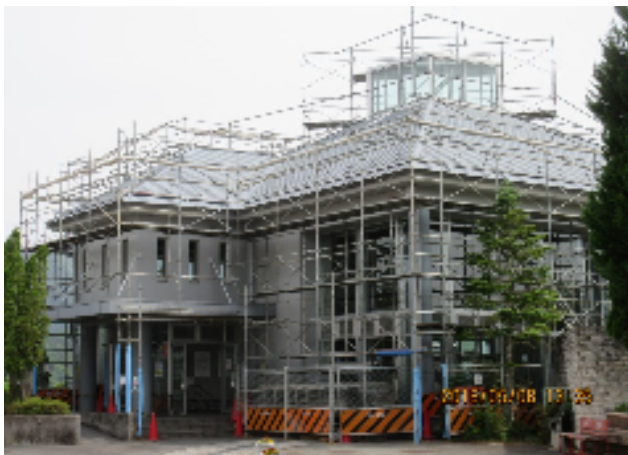
ステーション周りの足場
