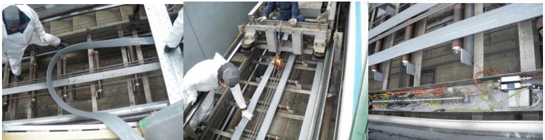
《制御ケーブル取替作業中》
