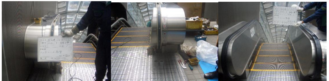
《古いハンドレール取り外し後》
