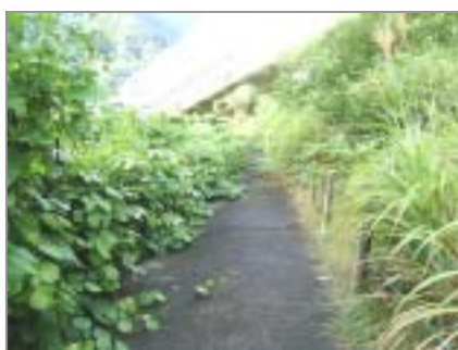
避難通路の様子
