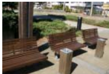
修理後の ベンチ
